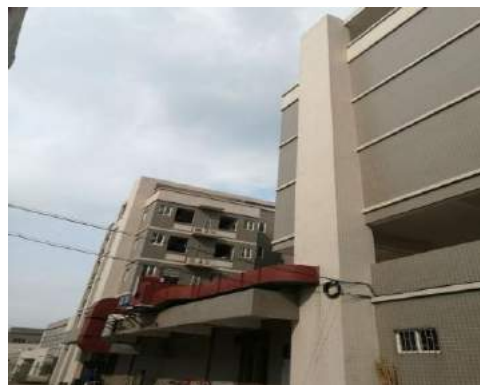
食堂油烟处理设施
