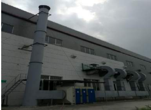
喷漆、刮灰废气处理设施
