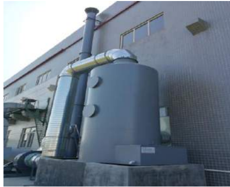
打磨废气处理设施
