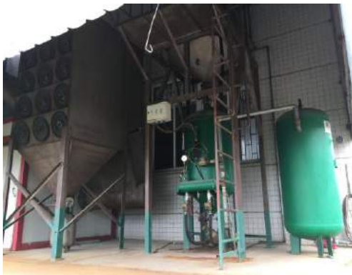
喷砂废气处理设施
